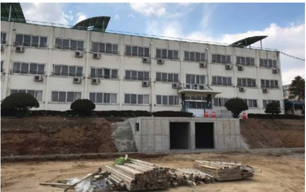
▲ 본관 나무바닥 공사, 운동장 마사토 교체 및 체육실(구령대) 설치 공사 중이다.
